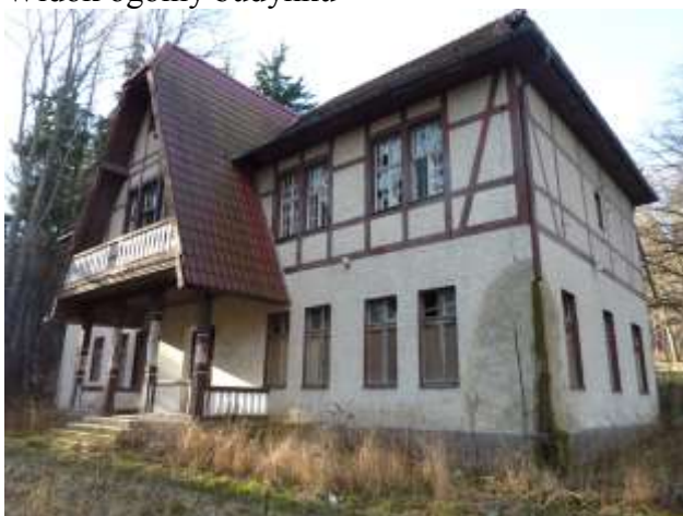
Widok ogólny budynku
