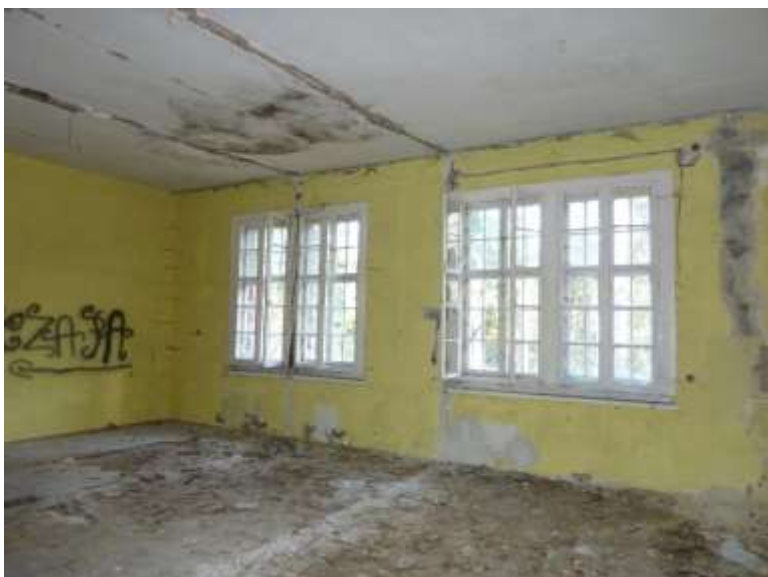
Strop nad piętrem do rozbiórki
