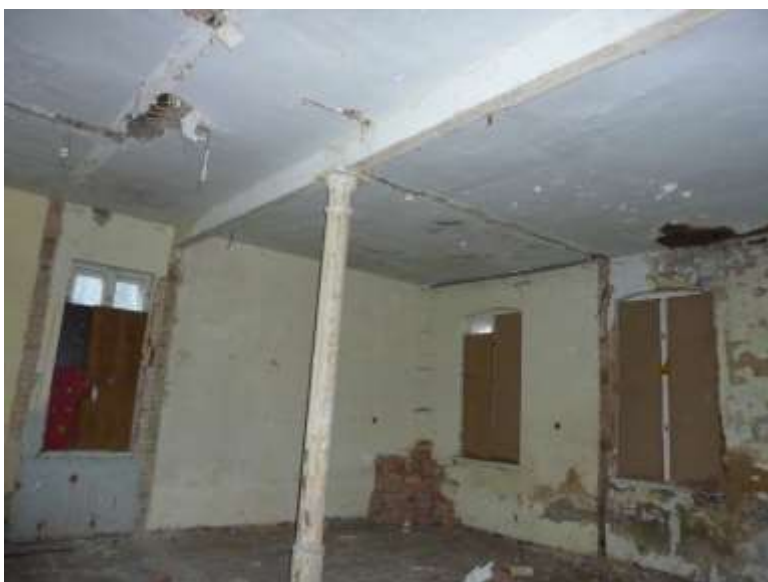
Strop nad parterem do rozbiórki
